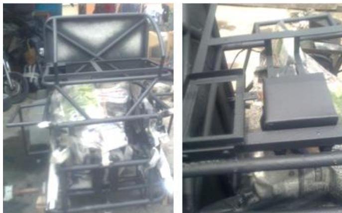
Fig. 4. 47 Proceso de Pintura al Agua del Chasis Tubular
