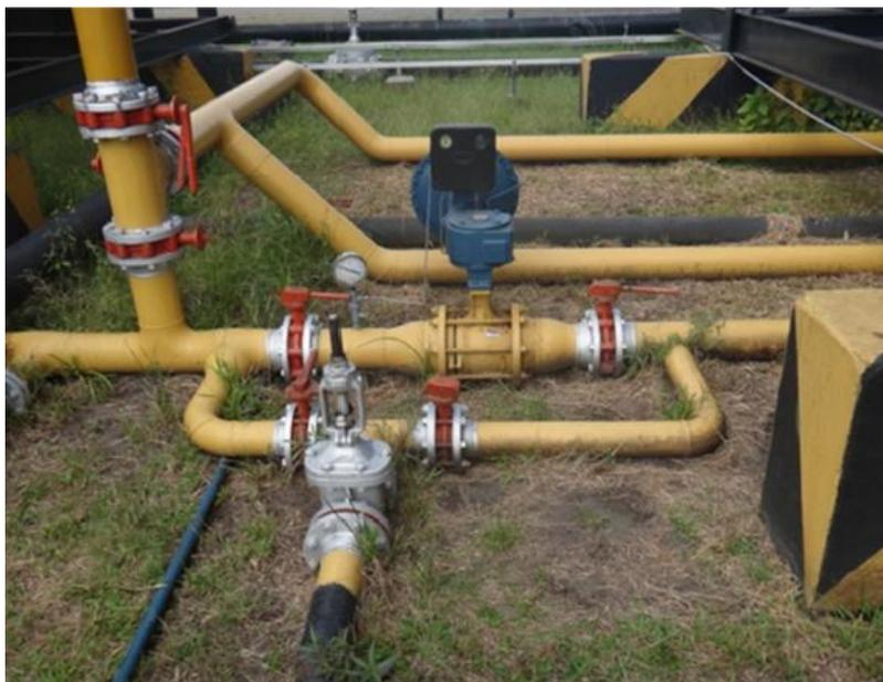
Figura 24. Sistema de venteo de gas de alta presión.
