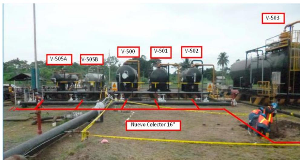
Figura 39. Nuevo Colector de producción.
