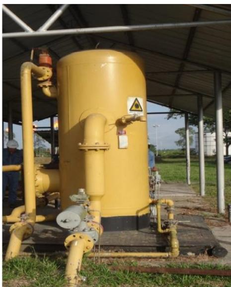
Figura 22. Sistema de tratamiento de gas combustible para calentadores.
