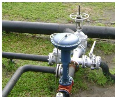
Figura 31. Válvula de salida separadores de producción.
