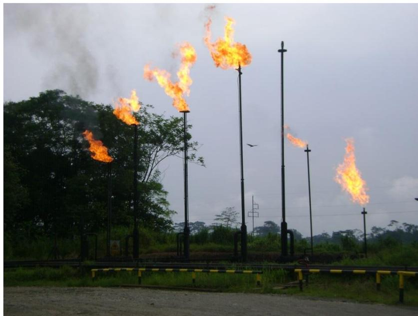
Figura 25. Sistema de estacas de venteo caliente alta presión.
