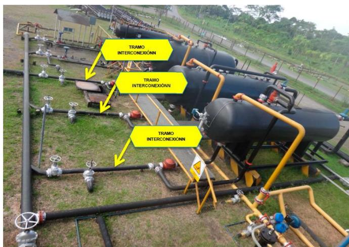
Figura 52. Interconexión del nuevo sistema de separación primaria con el colector
