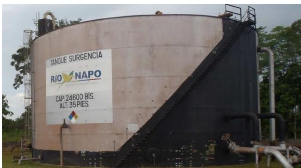
Figura 20. Bota y Tanque de almacenamiento.
