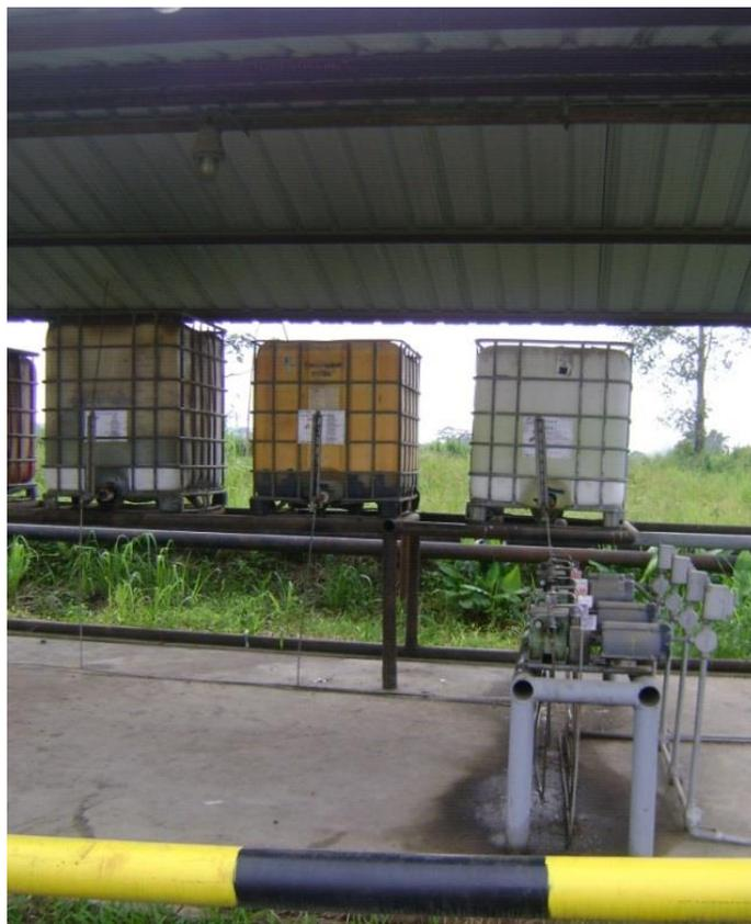
Figura 27. Sistema de inyección de químicos vista frontal.
