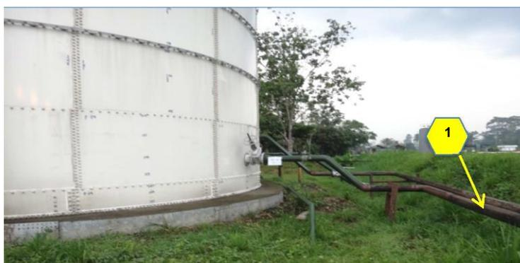
Figura 49. Interconexión sistema de control de nivel y desalojo de agua
