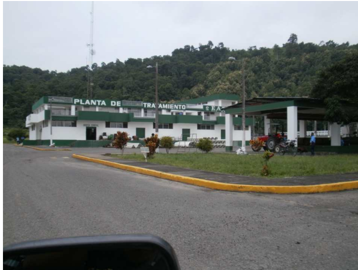
Figura 11. Vista frontal de planta de tratamiento de agua.
