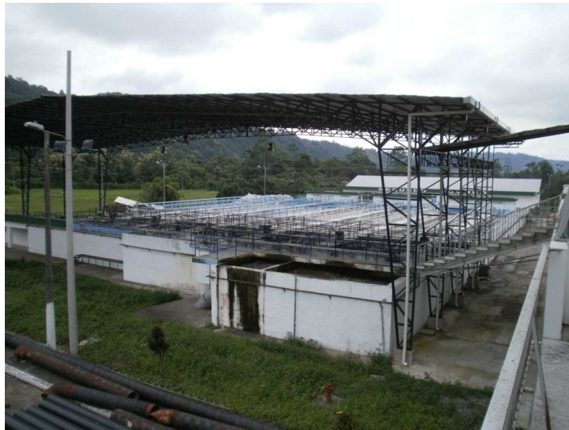
Figura 13. Módulo de potabilización.
