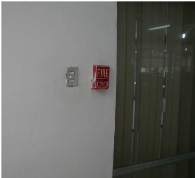
Figura 6. Interruptores para encender y apagar la luz dentro de la planta.
