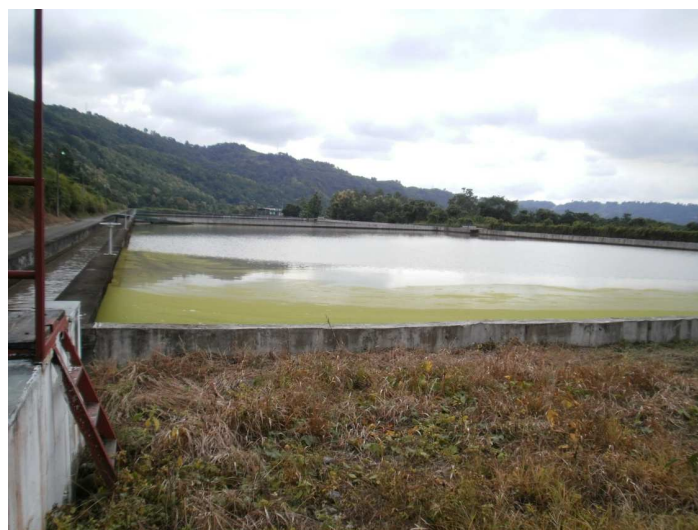
Figura 12. Lagunas de reserva o presedimentación.
