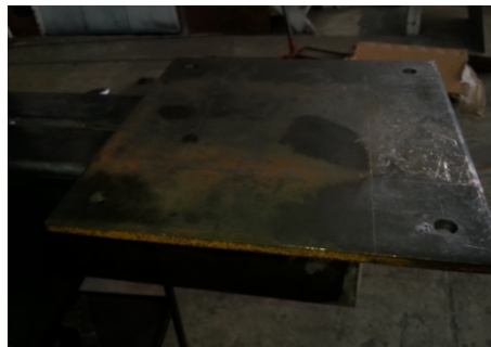
Figura 5.4: Soldadura de las bases de las columnas
