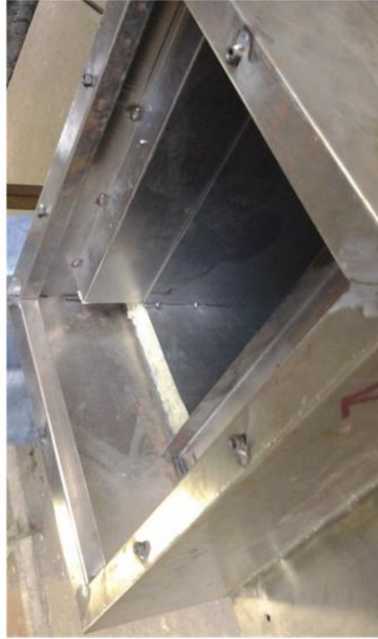
FIGURA 59. Instalación de tuercas.
