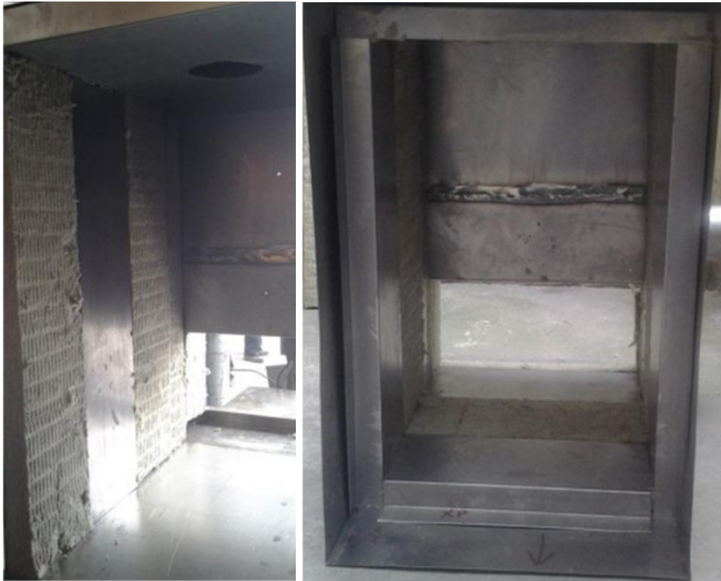
FIGURA 54. Construcción del Sanduche.
