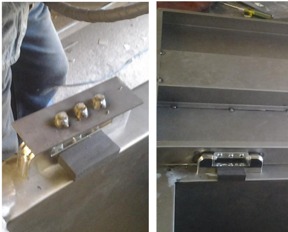
FIGURA 55. Instalación de las bisagras.
