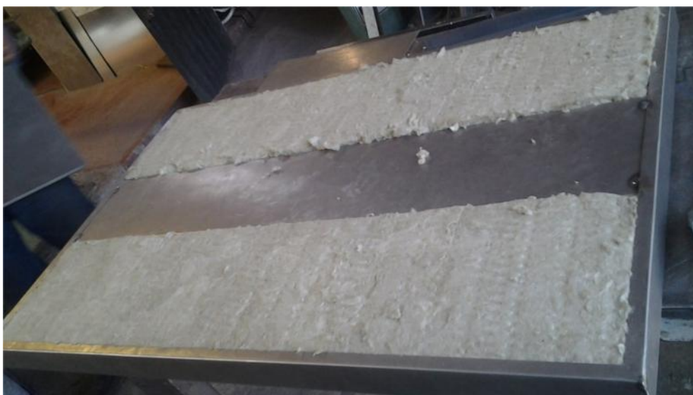
FIGURA 56. Relleno de lana de roca para la puerta.
