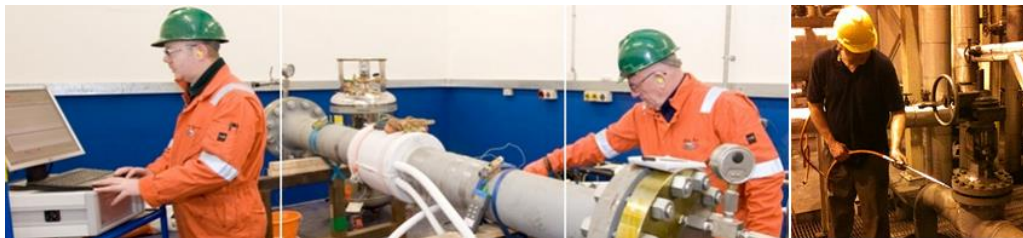
Figura 12. Detección de discontinuidades mediante el ensayo de fugas
