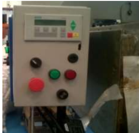
Figura 3. 15. Instalación del gabinete en el soporte de la banda transportadora
