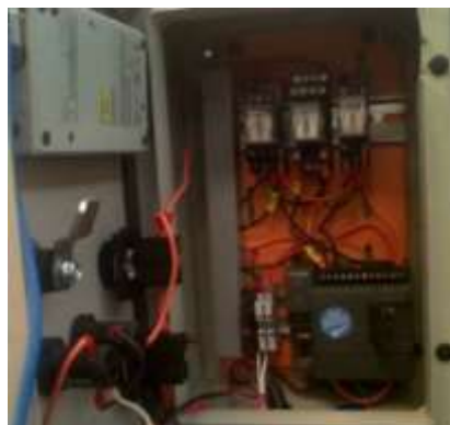
Figura 3. 14. Conexión y colocación de elementos eléctricos en el gabinete
