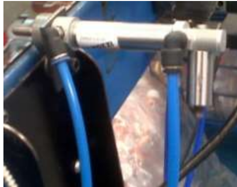
Figura 3. 19. Instalación de pistón semáforo
