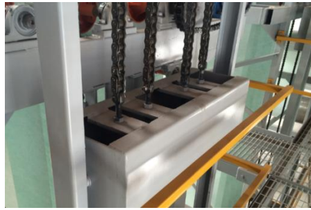
Ilustración 210: Cajón contrapeso instalado
