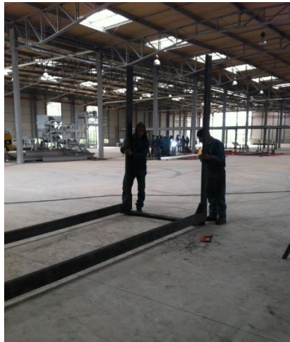
Ilustración 177: Ensamble de Base –Columna A y B
