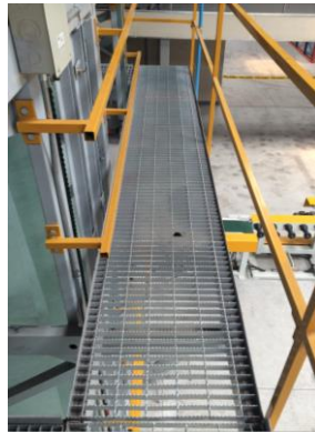
Ilustración 199: Grating instalado
