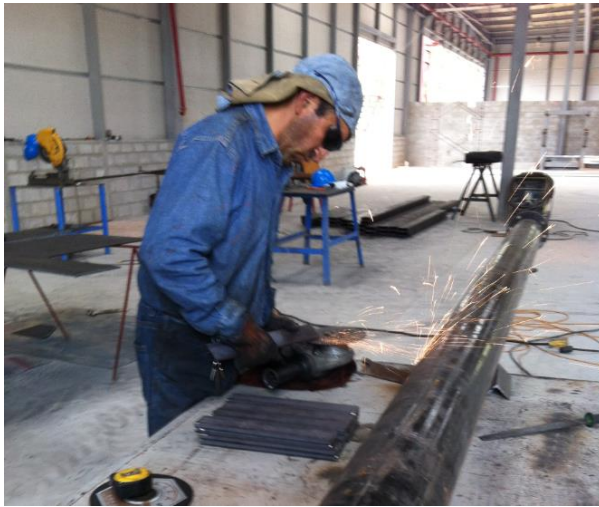
Ilustración 168: Corte de placas roscadas
