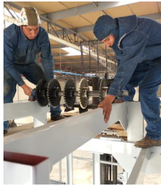
Ilustración 202: Instalación del Conjunto Piñones
