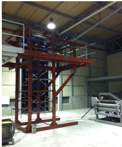
Ilustración 183: Estación pintada con pintura de fondo
