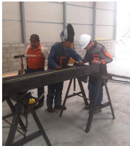
Ilustración 171: Medición de partes
