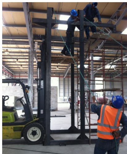
Ilustración 178: Montaje soporte superior izquierdo
