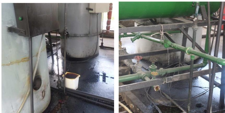
**Figura 21.** Fugas de aceite y agua en la Bomba de Almacenamiento.
