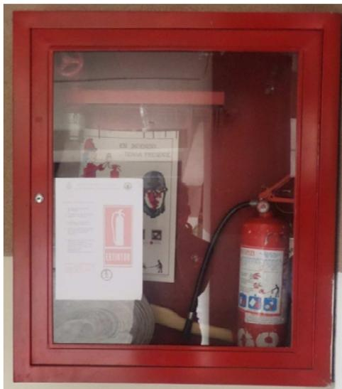
**Figura 63.** Extintor y Manguera para Incendios.
