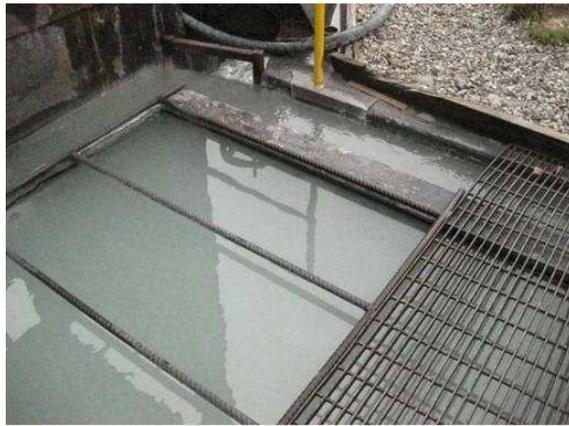
**Figura 52.** Planta de tratamiento, sedimentación primaria con Cal.
