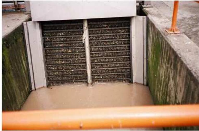
**Figura 54.** Malla o Barrera para tratamiento de aguas residuales.
