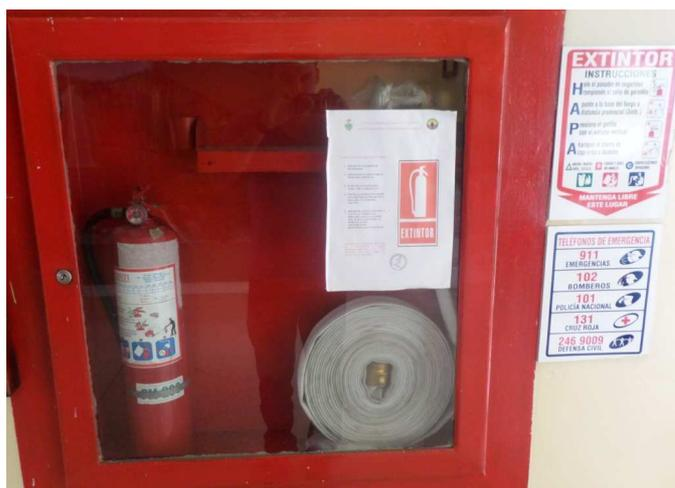
**Figura 59.** Extintor y Manguera para Incendios.
