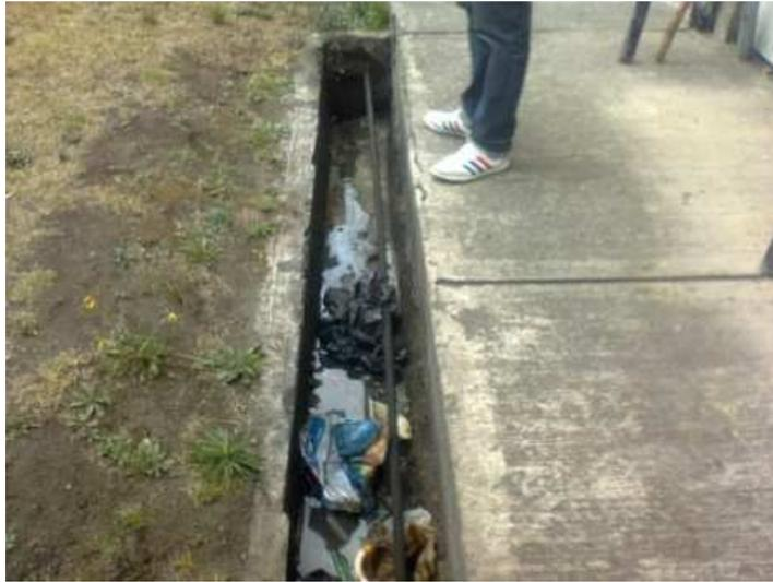
**Figura 15.** Derrame de aceites al alcantarillado interno.
