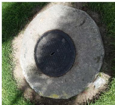
**Figura 42.** Caja de revisión previa a la descarga.
