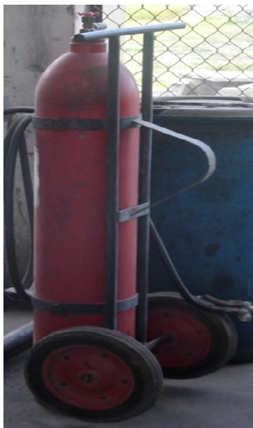
**Figura 20.** Extintor móvil para incendios o derrames químicos.
