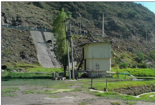
Figura 14. Sistema de captación de agua
