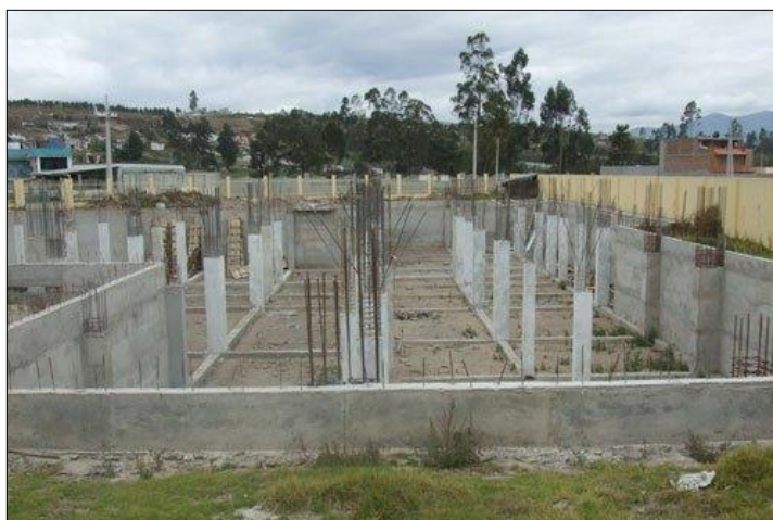
Figura 32. Hospital del Día de la Cruz Roja de Tungurahua en construcción Fuente: GAD Parroquial Izamba, 2014
