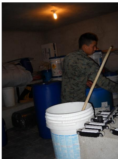
Figura 51. Bodega de productos químicos para piscinas
