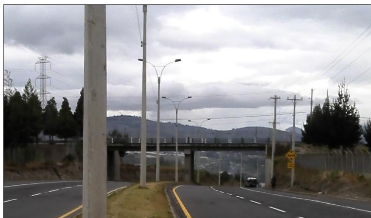
Figura 16. Puente sobre el Paso Lateral
