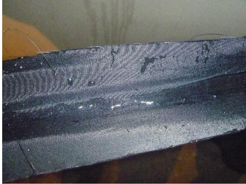
Figura 120: Resultado de la prueba de impermeabilidad.
