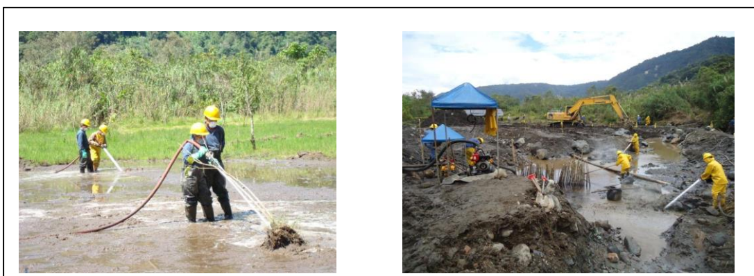
Figura N° 4 Imágenes de la segunda etapa de limpieza y remediación
