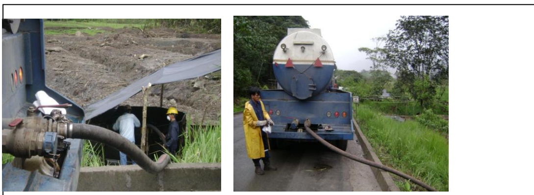
Figura N° 6 Imágenes de la cuarta etapa de limpieza y remediación
