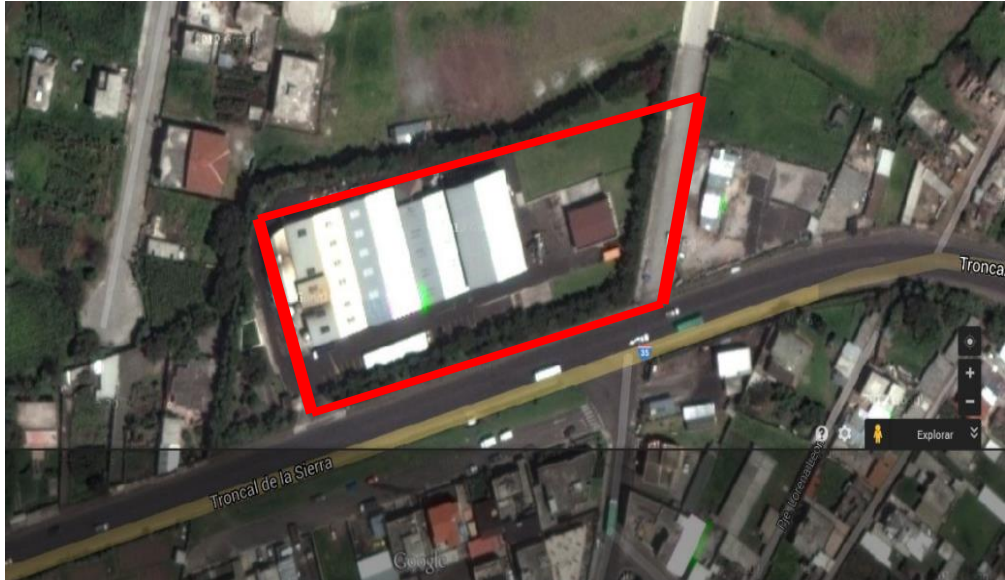
Figura 1. Vista aérea de la planta Industrial Chova del Ecuador S.A.
