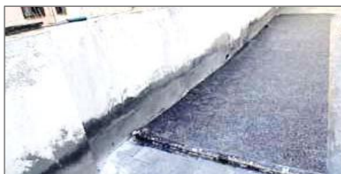
Fotografía 6. Impermeabilización de terraza con membrana EPDM
