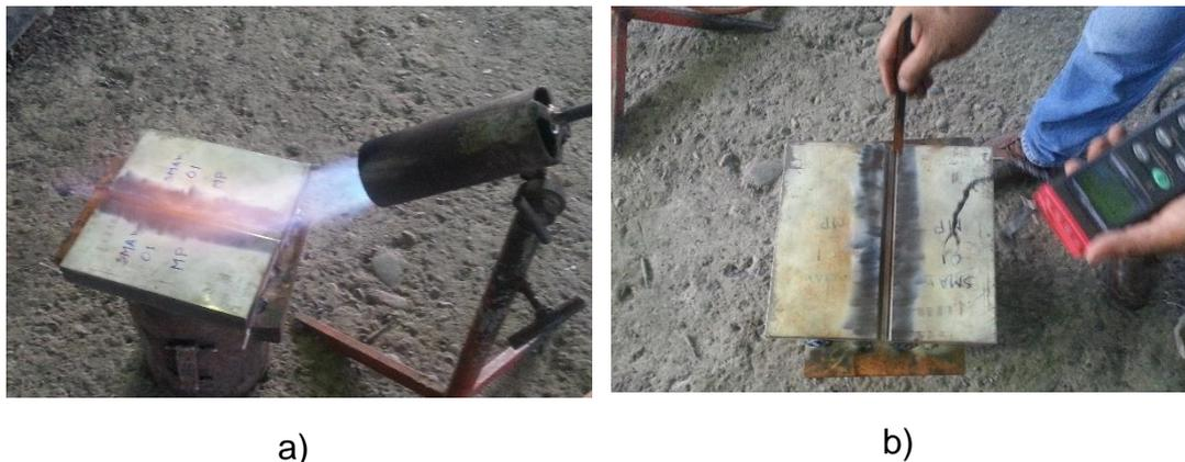
**Figura No. 42: a) Precalentamiento del procedimiento S01 b) Control de la temperatura de precalentamiento.**
