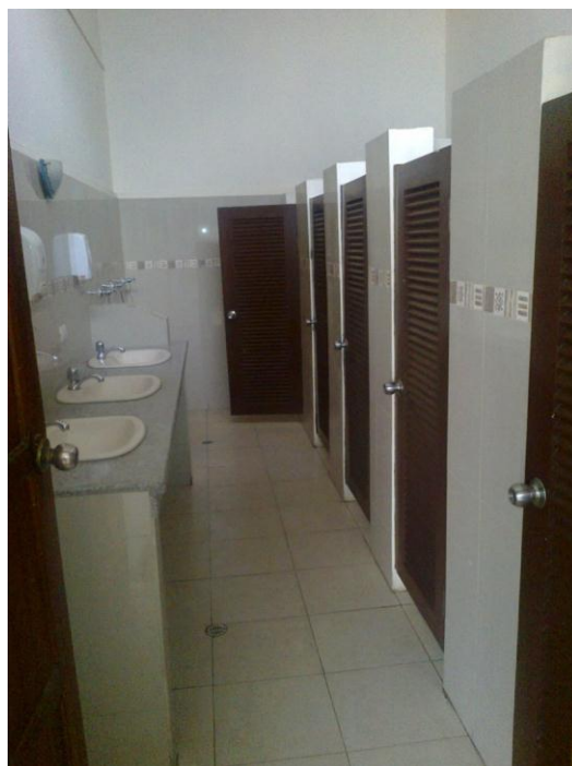
Fotografía 6. Baños del corredor de las aulas
