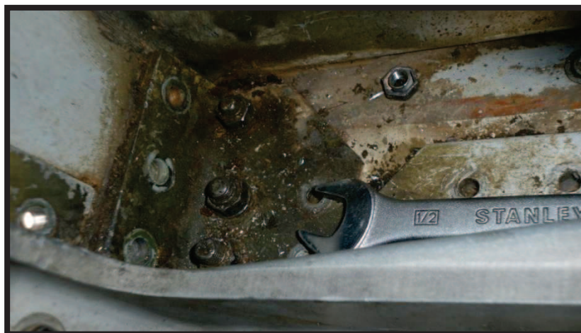
Figura 3.18 Remoción pernos interior que une las dos alas
