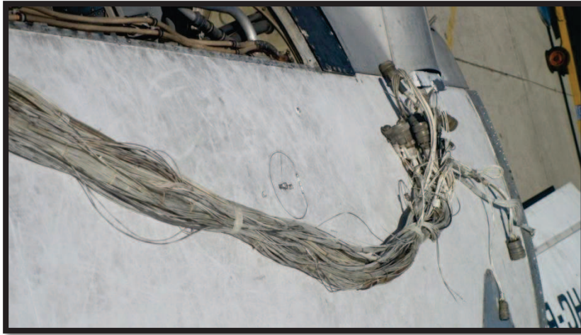
Figura 3.9 Sistema eléctrico desconectado
