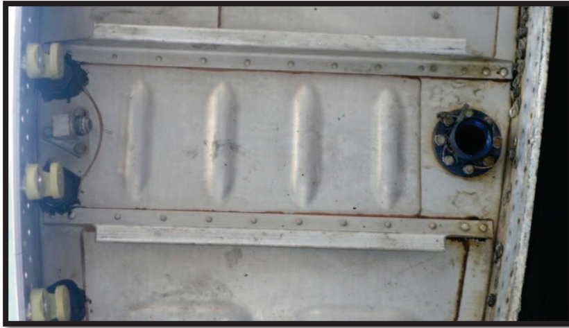
Figura 3.13 Línea de combustible
