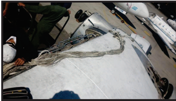
Figura 3.7 Desconexión del sistema eléctrico
