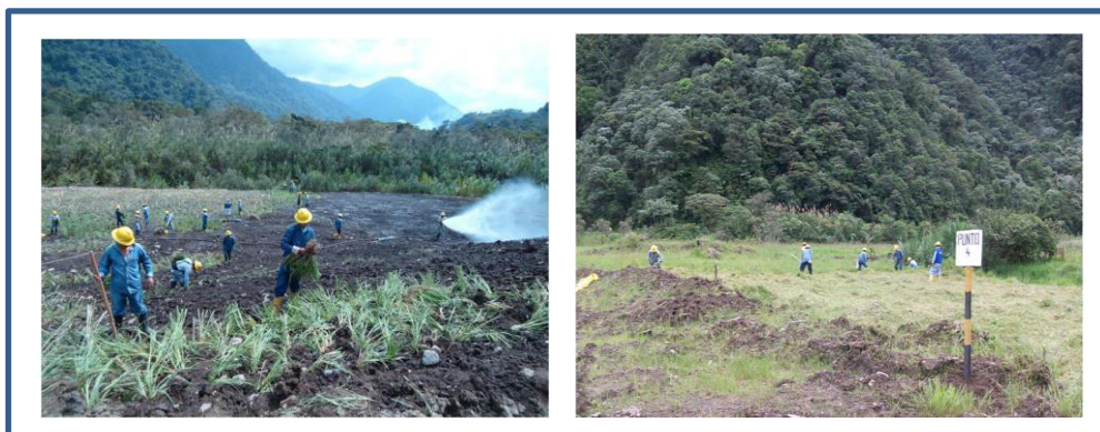
FIGURA 9: Imágenes de la octava etapa de limpieza y remediación
