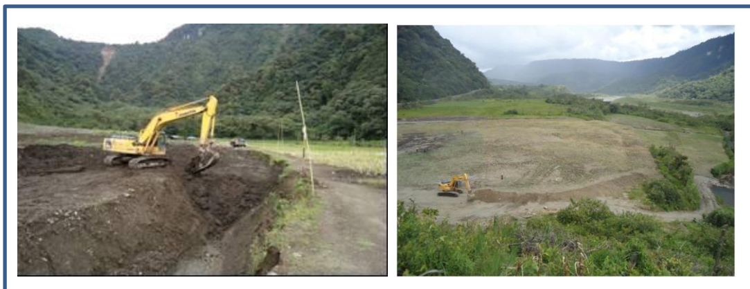
FIGURA 8: Imágenes de la séptima etapa de limpieza y remediación
