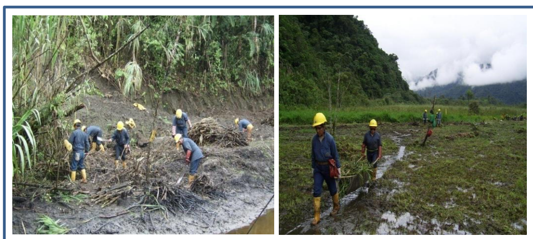
FIGURA 2: Imágenes de la primera etapa de limpieza y remediación
