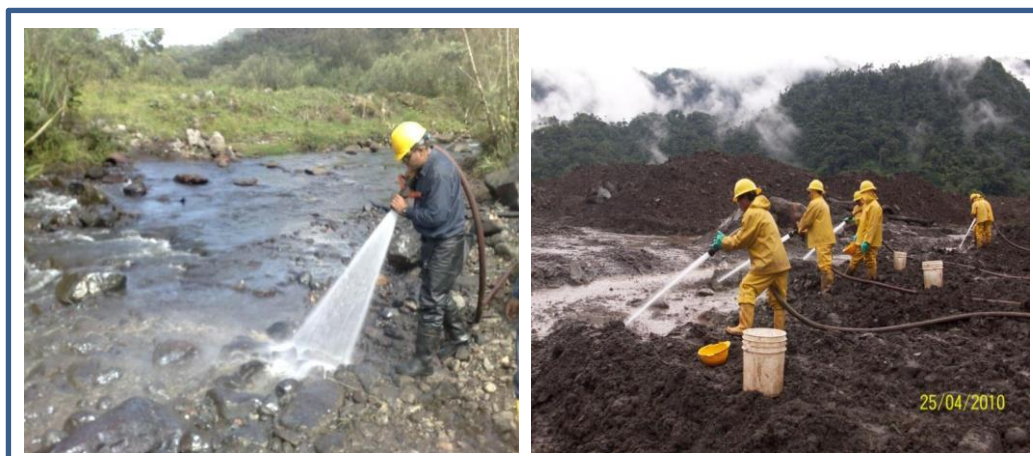
FIGURA 3: Imágenes de la segunda etapa de limpieza y remediación Fuente: Archivo personal perteneciente a la GSSA de Ep Petroecuador/MRA
