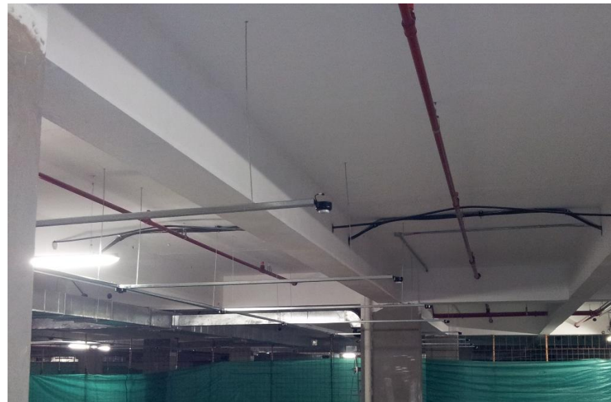
Figura 4.9 Instalación de canaletas, cableado y sensores del sistema electrónico.
