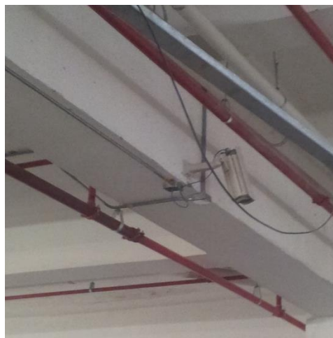
Figura 4.10 Instalación de cámara
