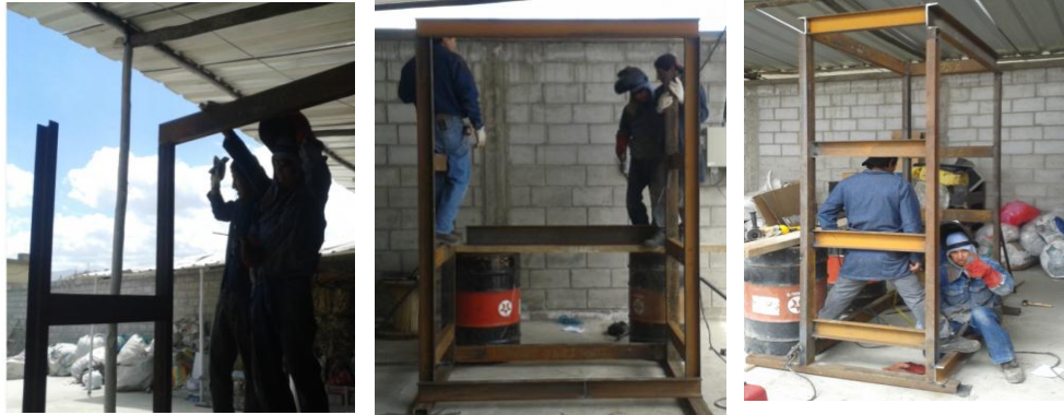
Figura No. 87: Estructura principal.
