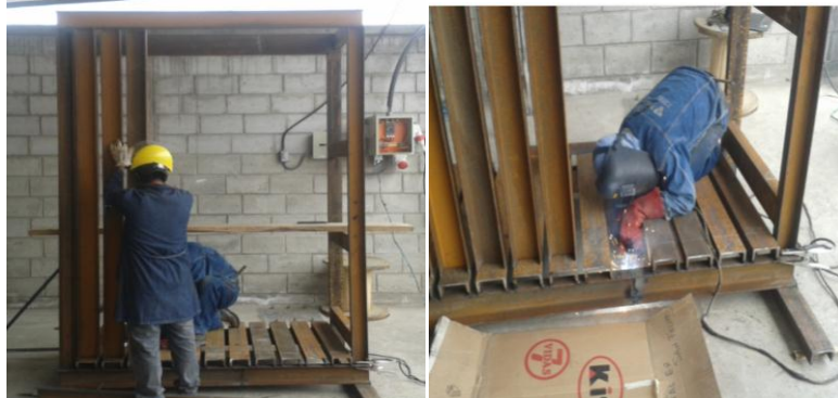
Figura No. 88: Columnas de la estructura.
