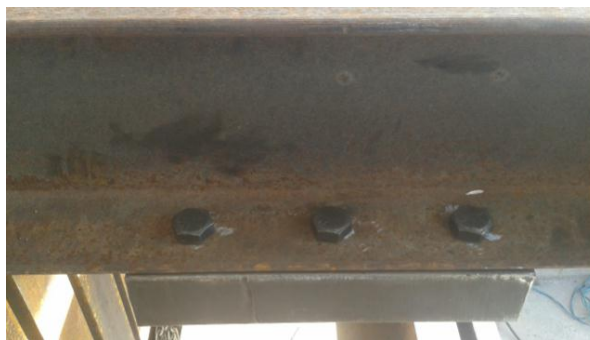
Figura No. 85: Unión por pernos.
