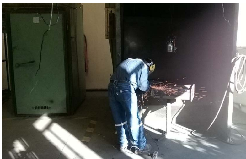
Figura 61. Soldadura de las Bases
