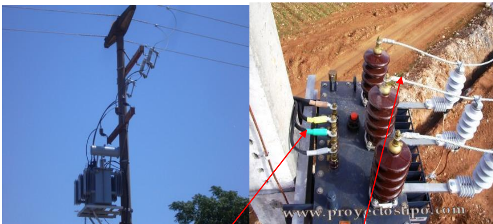
Figura 18: Puntas terminale en 220 V, y terminales en 13.8 Kv.
