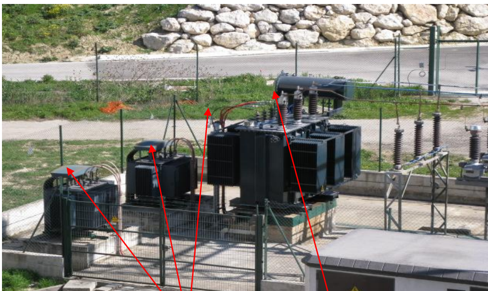
Figura 18: Puntas terminale en 220 V, y terminales en 13.8 Kv.
