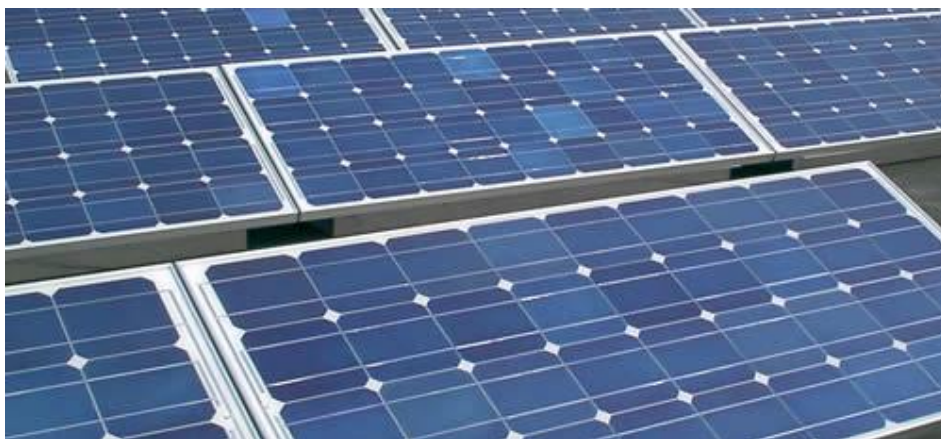
Imagen 16. Paneles Solares - Energía Solar Fotovoltaica
