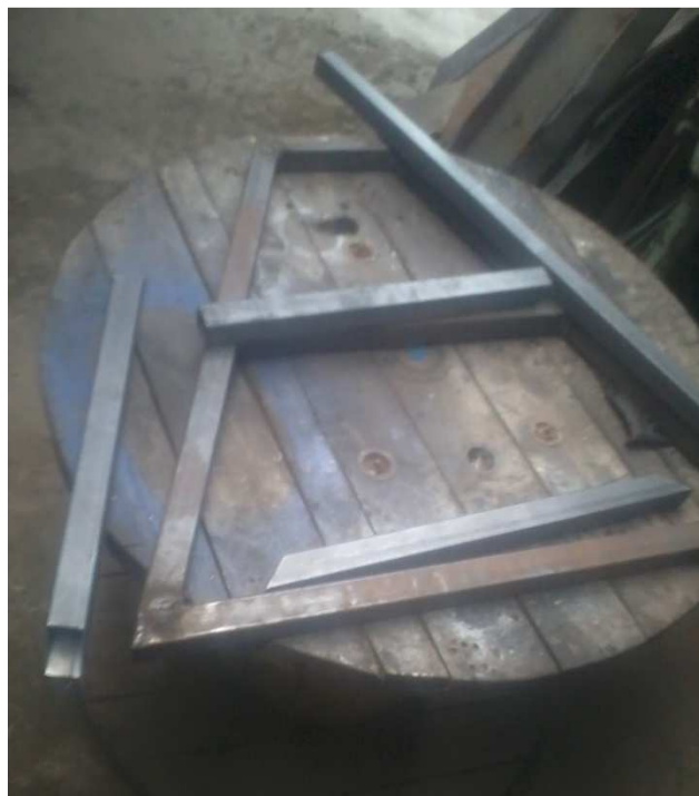
Figura 38 Proceso de corte de tubo cuadrado para estructura
