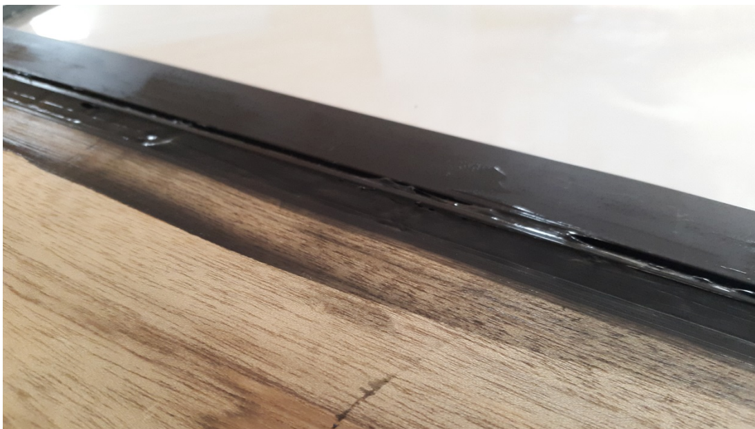
Figura 3.16 Sellado con silicona
