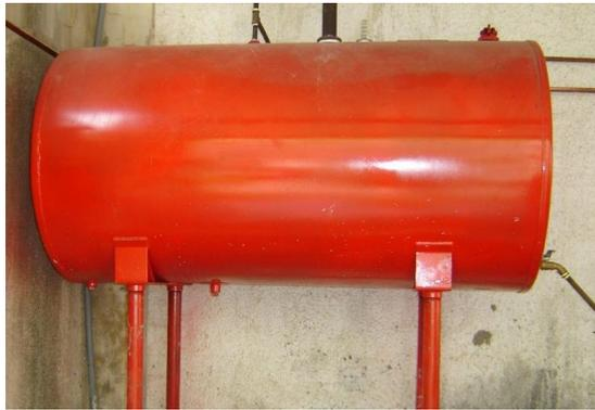
Figura 19. Tanque Diésel UL/FM, capacidad 300 galones
