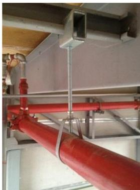
Figura 69. Soportes tipo pera usados en la mallas de rociadores
