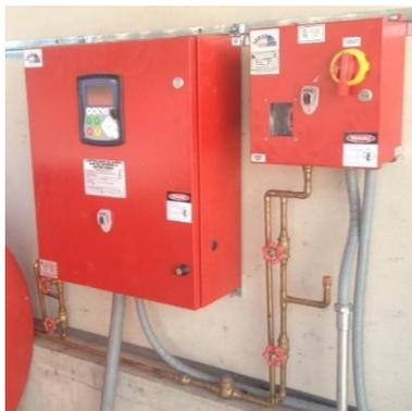
Figura 56. Instalación de los tableros dentro del cuarto de bombas
