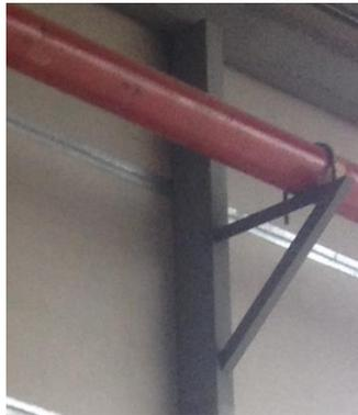
Figura 68. Soporte instalado tipo ménsula
