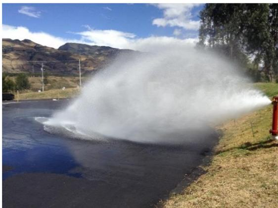
Figura 71. Lavado de tubería en Hidrante de Parqueaderos
