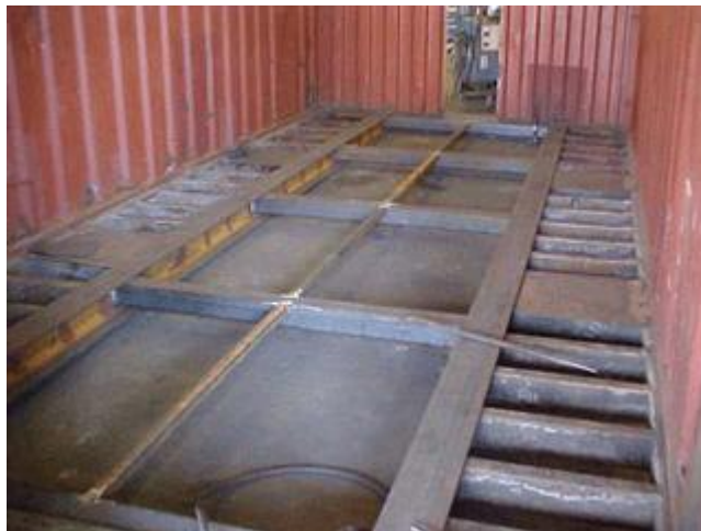
Figura 2.8. Estructura interna de un contenedor de 40ft
