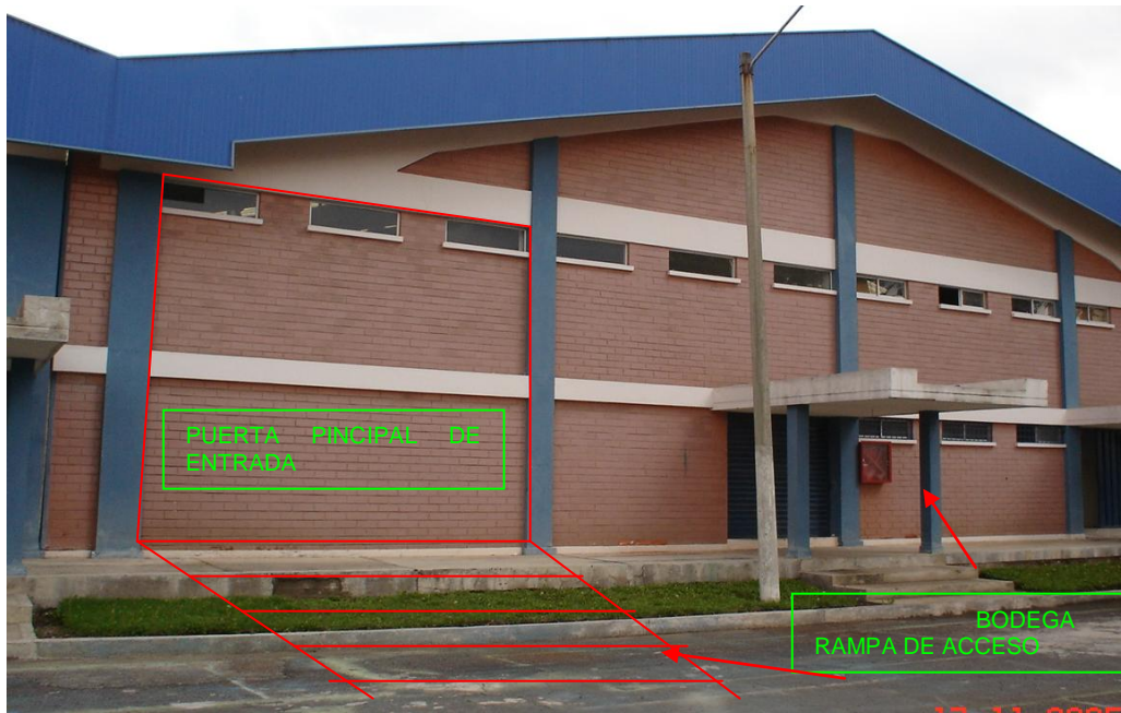
Figura 5.4. Ingreso de contenedores y pared a ser derrocada
