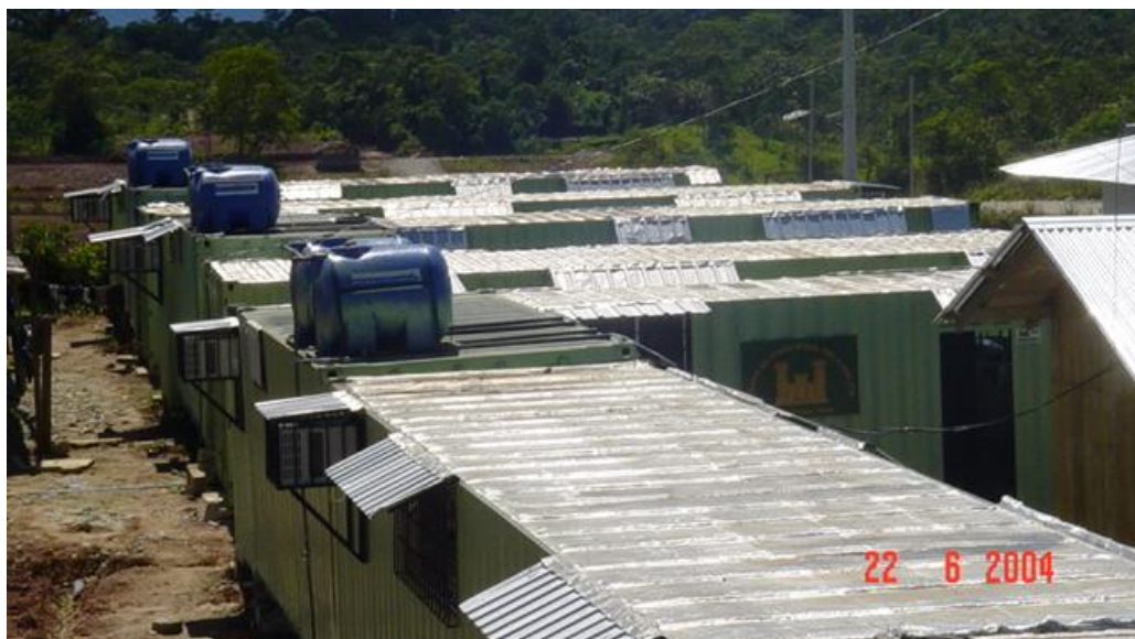
Campamento desmontable del CEE-Grupo Vial Tena
