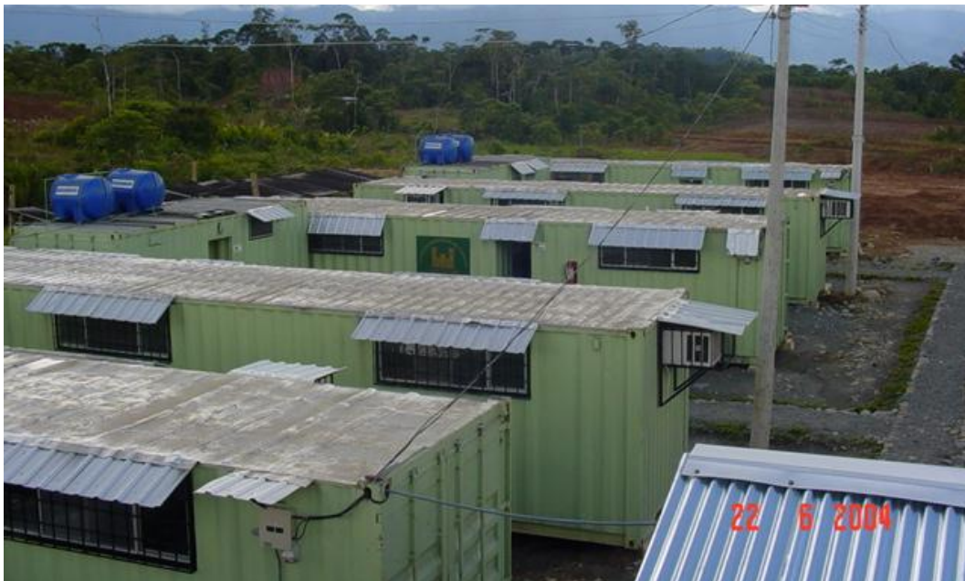
Dormitorios de personal operativo del Campamento desmontable del CEE-Grupo Vial Tena
