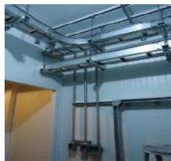
**Figura 2.35. Ruta de bandejas y conduit en un PCR Contenerizado**
