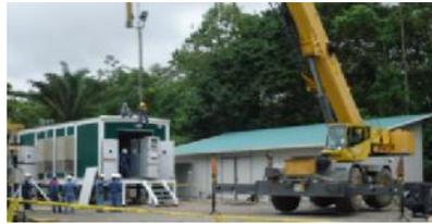
**Figura 2.36. Izaje y transporte de PCR Contenerizado**
