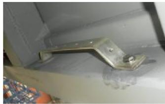
**Figura 4.35. Barra de conexión de sistema de tierra de PCR Contenerizado con estructura y facilidades de conexionado a malla de tierra de plataforma**
