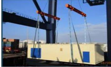
**Figura 2.24. Izaje PCR Contenerizado**
