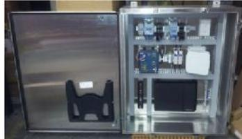
**Figura 4.28. Tablero de Comunicaciones Switch / FO**
