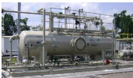
**Figura 2.10. Separador horizontal trifásico PAM**
