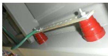
**Figura 4.36. Barra de conexión de sistema de tierra de PCR aislada de estructura y facilidades de conexionado a malla de tierra de plataforma**
