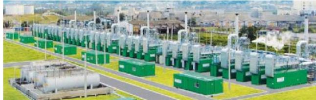
**Figura 2.40. Plataforma integrada con equipos contenerizados (Planta Eléctrica Hyundai, 47,6MW, Cuba)**
