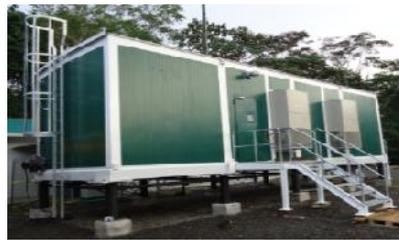
**Figura 2.45. PCR Contenerizado de dimensiones y características manejables, con aislamiento térmico, facilidades para operación y mantenimiento, servicios auxiliares y sistema de climatización**
