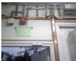
**Figura 3.32. Sistema de Tierra PCR Wati Repsol**
