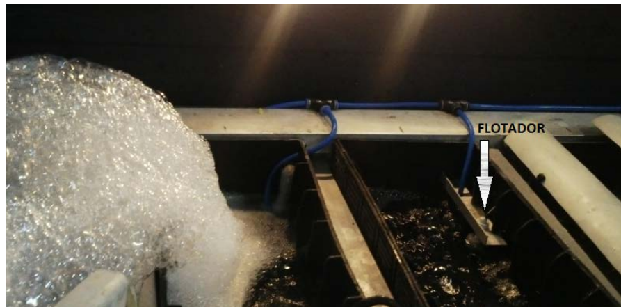
Figura 3.24 Flotador magnético plástico cuba de enjuague
