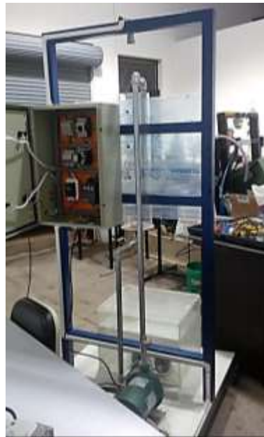
Figura 3. 38. Tablero de Protección
