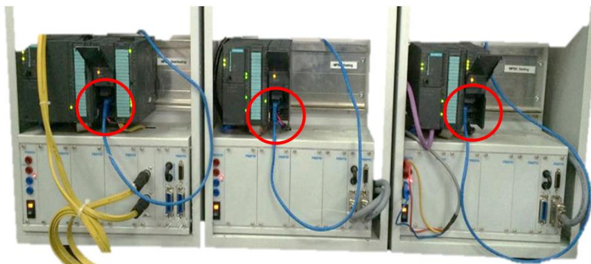
Figura 3.10. Conexión de cables Ethernet a los módulos de comunicación.
