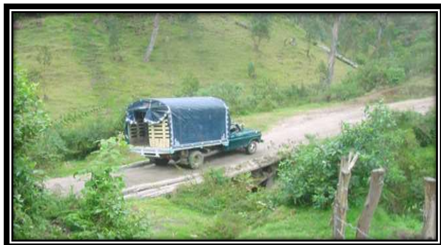
Figura No. 15 Puente Sector el Carmelo
