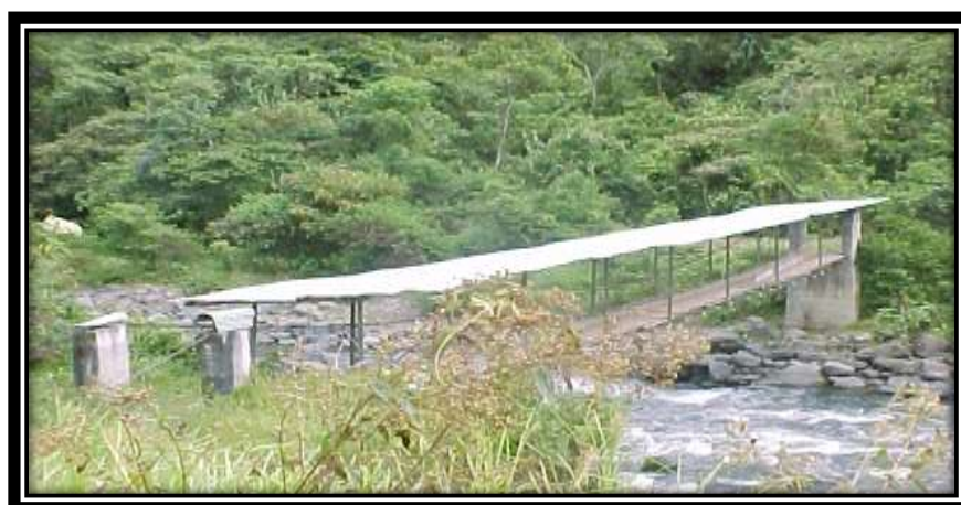
Figura No. 27 puente la Chorrera-la Unión
