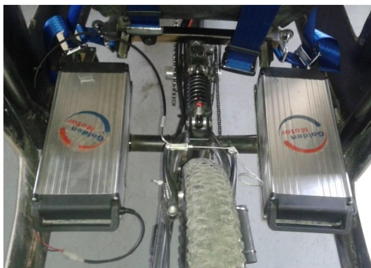
Figura 4.0.23: Baterías montadas en la tricicleta
