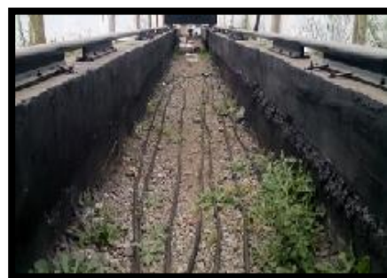
Fig. 15 VISTA REAL DE LAS COLUMNAS
