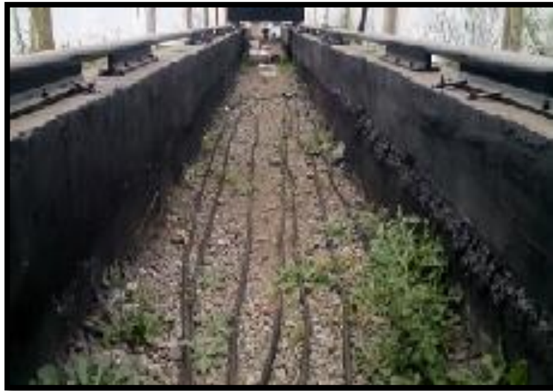
Figura 3.4: Vista real de las columnas.
