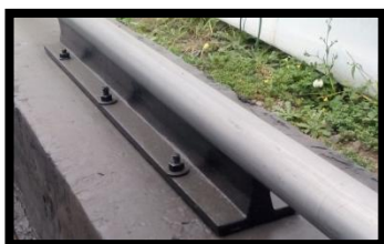
Fig. 18 ANCLAJE HACIA LA COLUMNA
