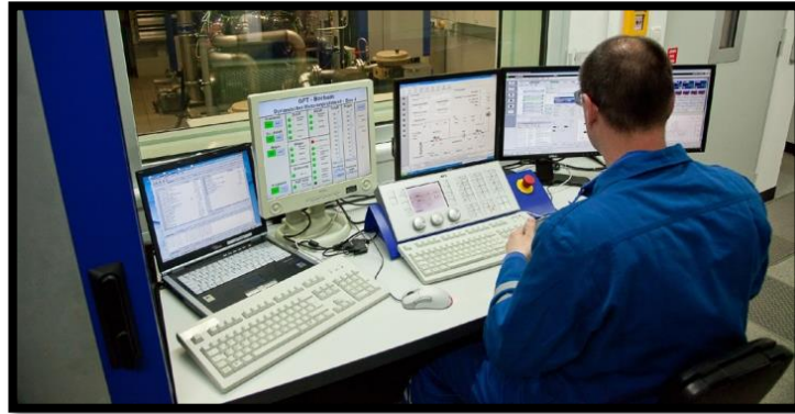
Figura 1.13: Sala de supervisión y control
