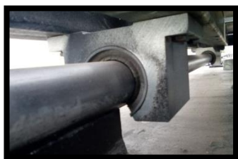
Fig. 21 COLOCACIÓN DE RODAMIENTOS AL TRINEO
