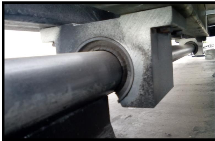
Figura 3.16: Colocación de rodamientos al trineo.
