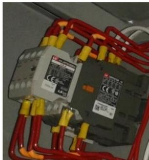
**Figura 3.13. Contactor y auxiliares del contactor.**
