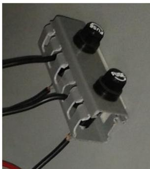
**Figura 3.14. Fusibles para la protección de equipos.**
