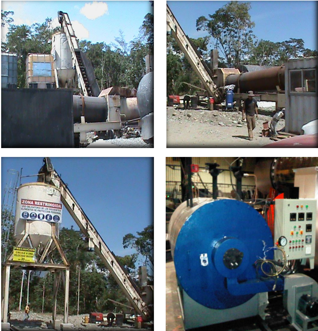
Figura 3.5.- Área de producción de mezcla asfáltica
