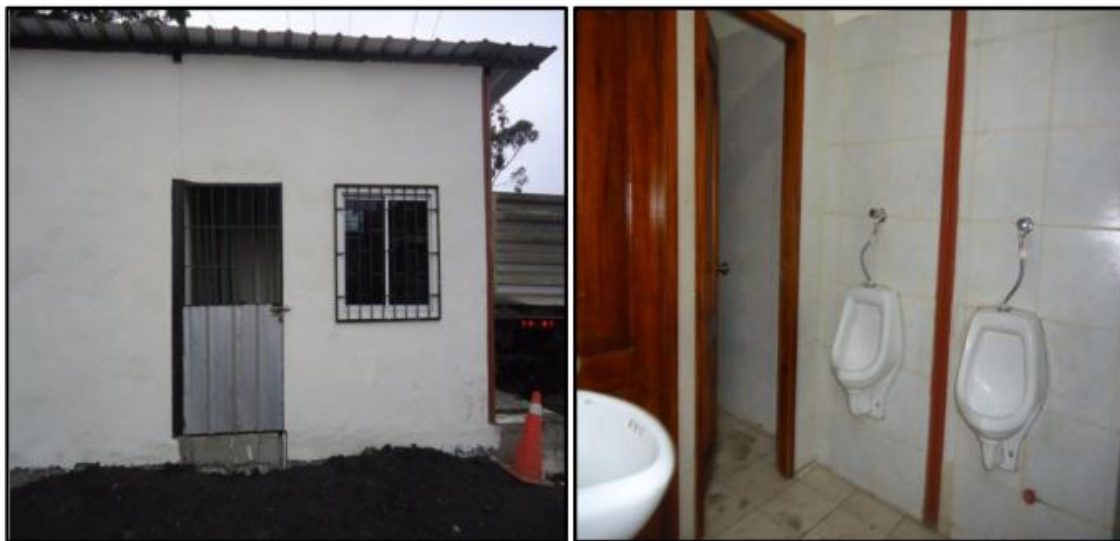
Figura 3.3.- Instalaciones del área administrativa
