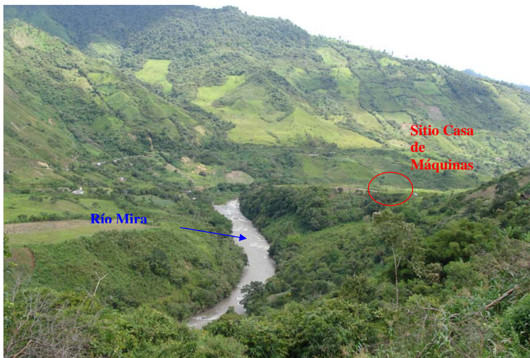
Foto 5.1: Vista del sitio de Casa de Máquinas Fuente: Autor
