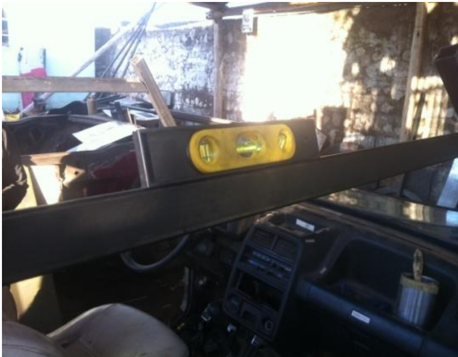
Figura 3.14: Nivelación de los tubos
