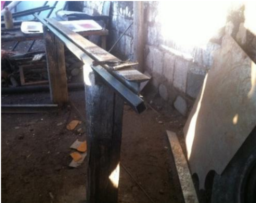
Figura 3.12: Medición y corte de tubos
