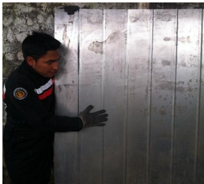
Figura 3.24: Techo con los canales diseñados
