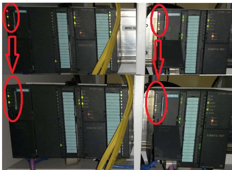
Figura 3.25: Esclavos Profibus de estado fallido a funcionamiento correcto
