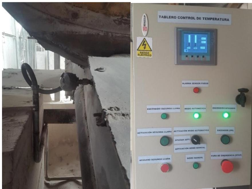
**Figura 3.8. Control de temperatura implementado.**
