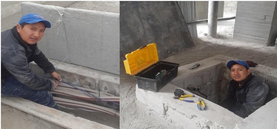
**Figura 3.1. Tendido de cable eléctrico**
