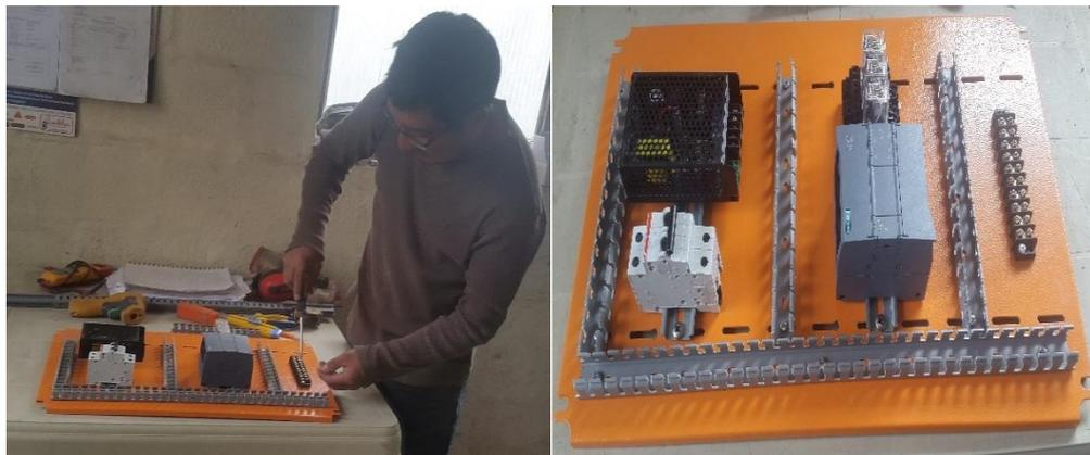
**Figura 2.25. Ubicación de los elementos en el tablero.**
