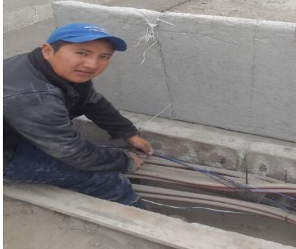
Figura 13: Tendido de cable eléctrico
