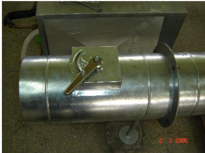
**Figura 6.6 Ducto con compuerta tipo mariposa**
