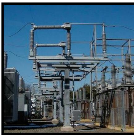
**Figura 2.3: Seccionador de línea**
