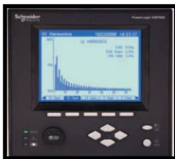
**Figura 2.11: Relé de Medición ION 7650**
