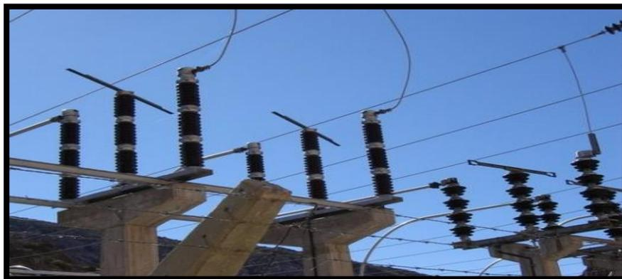
**Figura 2.6: Seccionador de columnas giratorias**
