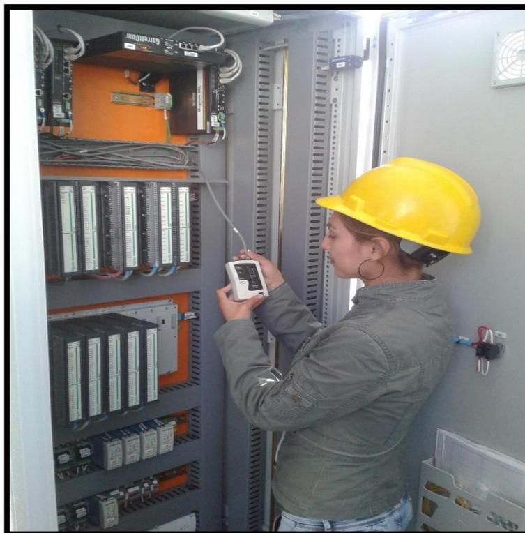
**Figura 4.2: Pruebas de conectividad con el concentrador de datos**
