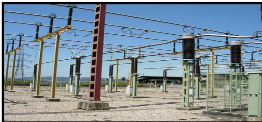
**Figura 2.7: Seccionador de pantógrafo**
