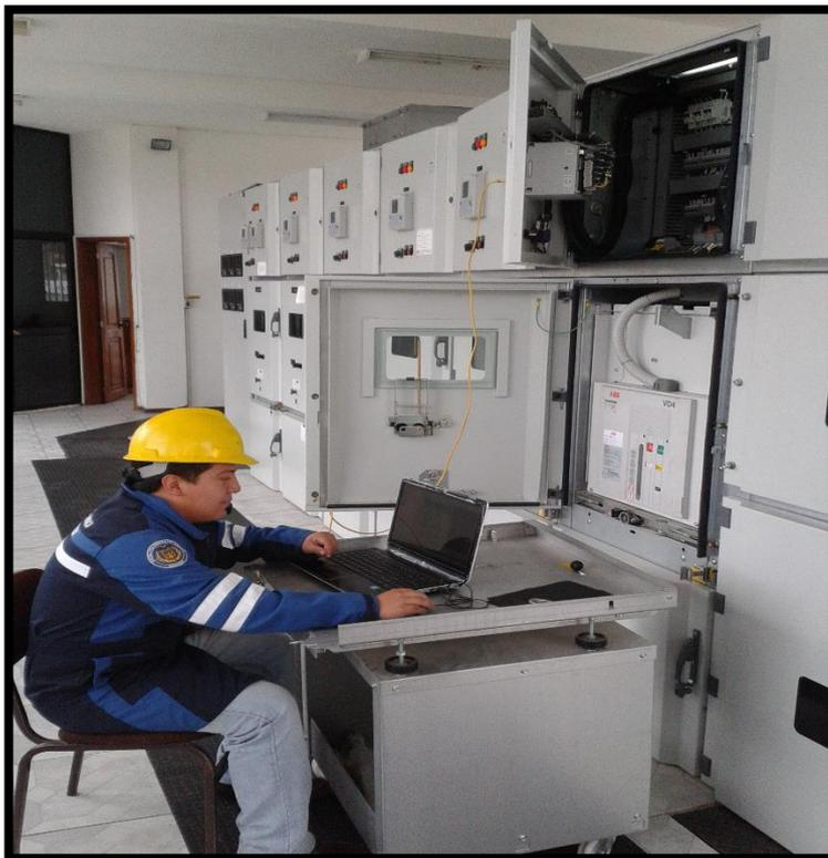
**Figura 4.1: Pruebas de conectividad con IED's**
