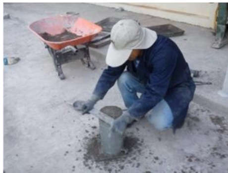
Figura 26. Enrasado del cilindro metálico.
