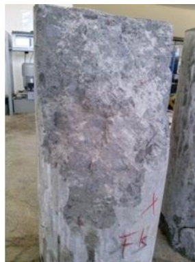
Figura 52. Falla tipo transversal.
