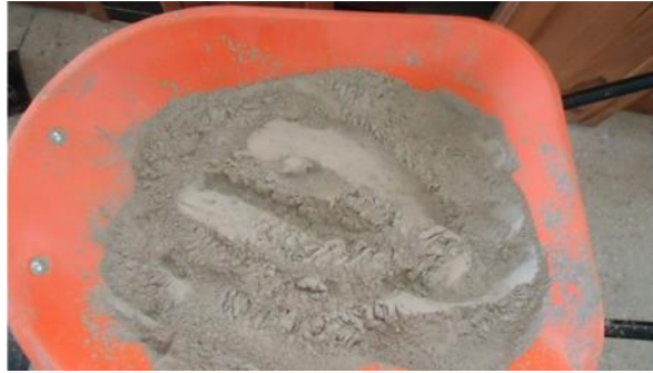
Figura 12. Cemento, imbrita y arena.
