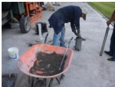
Figura 21. Colocación de mezcla de hormigón en los moldes.
