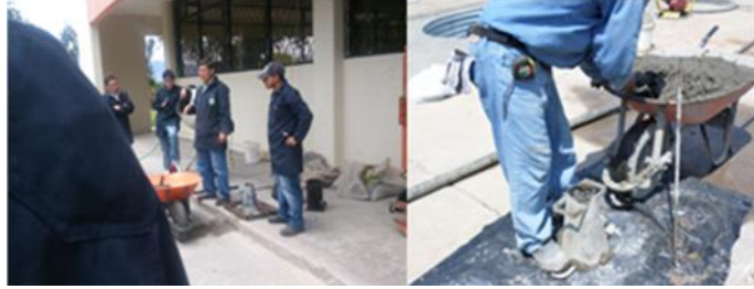
Figura 19. Asentamiento del HAD sin aditivos químicos.
