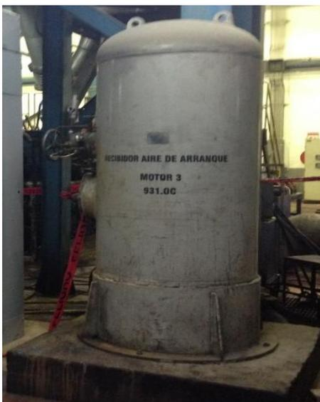
**Figura 14.** Aire de arranque del motor.
