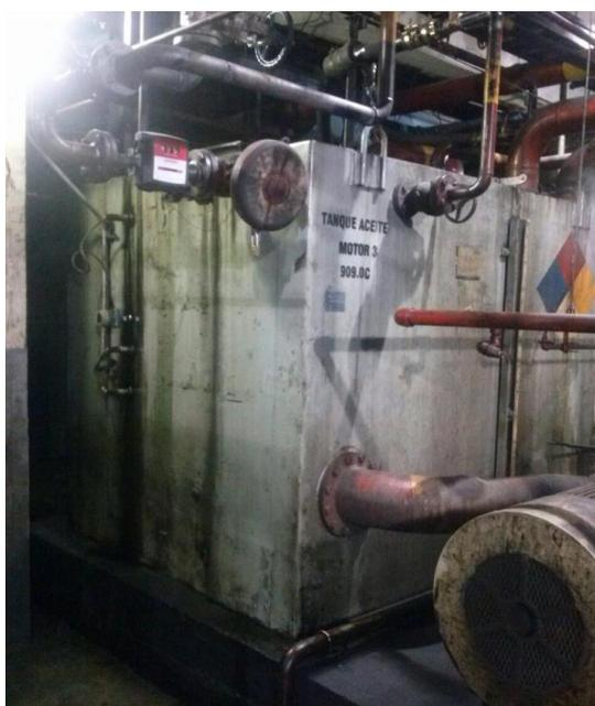
**Figura 13.** Tanque aceite lubricante.
