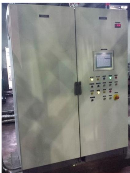
**Figura 27.** Tablero de control del motor generador 1.
