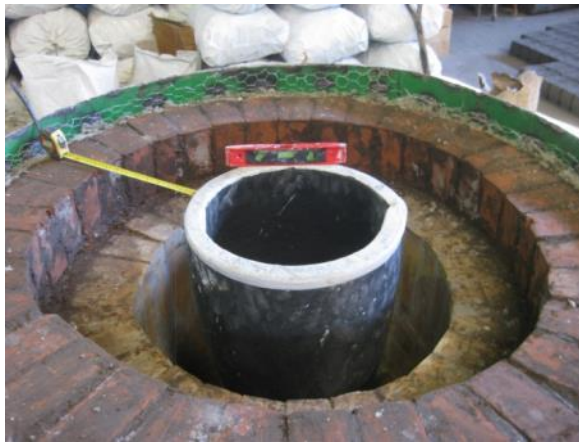
Figura 38. Colocación y nivelación de crisol
