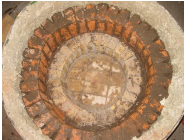
Figura 35. Colocación de ladrillo refractario y aislante en base y paredes del horno
