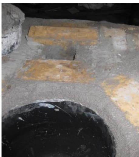
Figura 40. Colocación de chimenea
