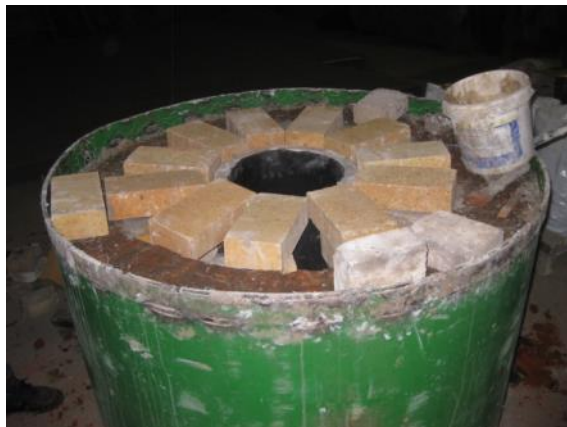
Figura 39. Colocación y cierre de horno con ladrillos refractario
