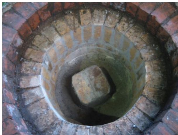
Figura 36. Colocación de base de crisol
