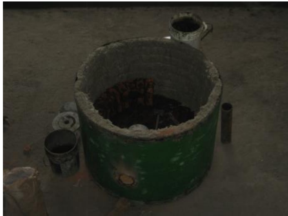
Figura 34. Colocación de fibra de vidrio al interior del tanque
