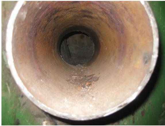
Figura 37. Colocación de tubo de 5" ingreso de quemador
