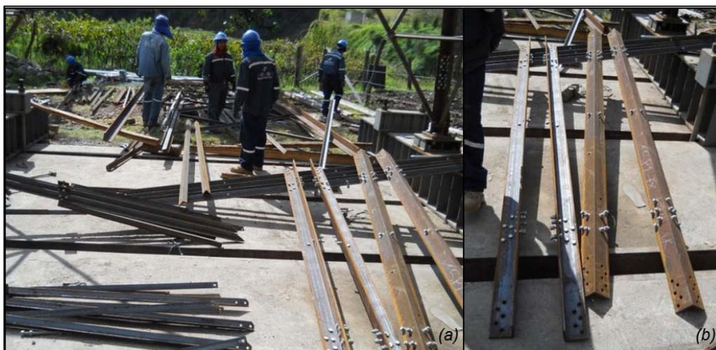
**Figura 121.** Clasificación de elementos, placas y perneria; (a) tramos clasificados; (b) montantes con pernos
