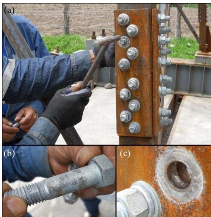
**Figura 135.** Inspección de placa más crítica en Torre SP2+3; (a) extracción de muestras; (b) superficie marcada por del perno; y (c) inspección de borde de agujero.
