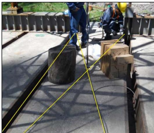
**Figura 92.** Anclaje de cable de carga vertical en cúpula
