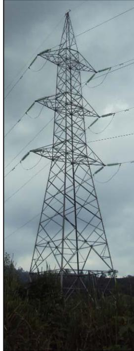
**Figura 10.** Torres eléctricas autoportadas de suspensión
