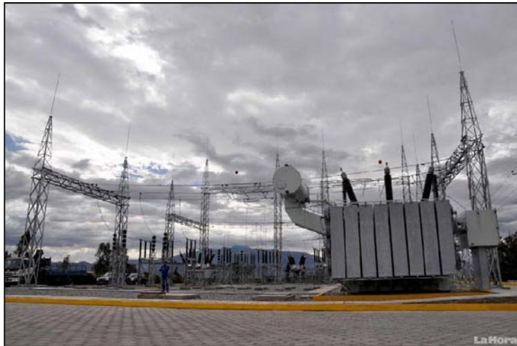
**Figura 1.** Subestación eléctrica Tababela, capacidad de 33 MVA.
