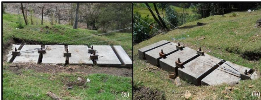
**Figura 26.** Cimentación para cables de carga y soporte. (a) cimentación de carga transversal y soporte; (b) cimentación de carga longitudinal y soporte.
