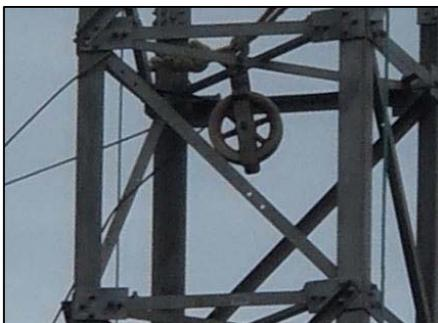
**Figura 100.** Polea de torre guía de diámetro 7'' y capacidad 6 toneladas
