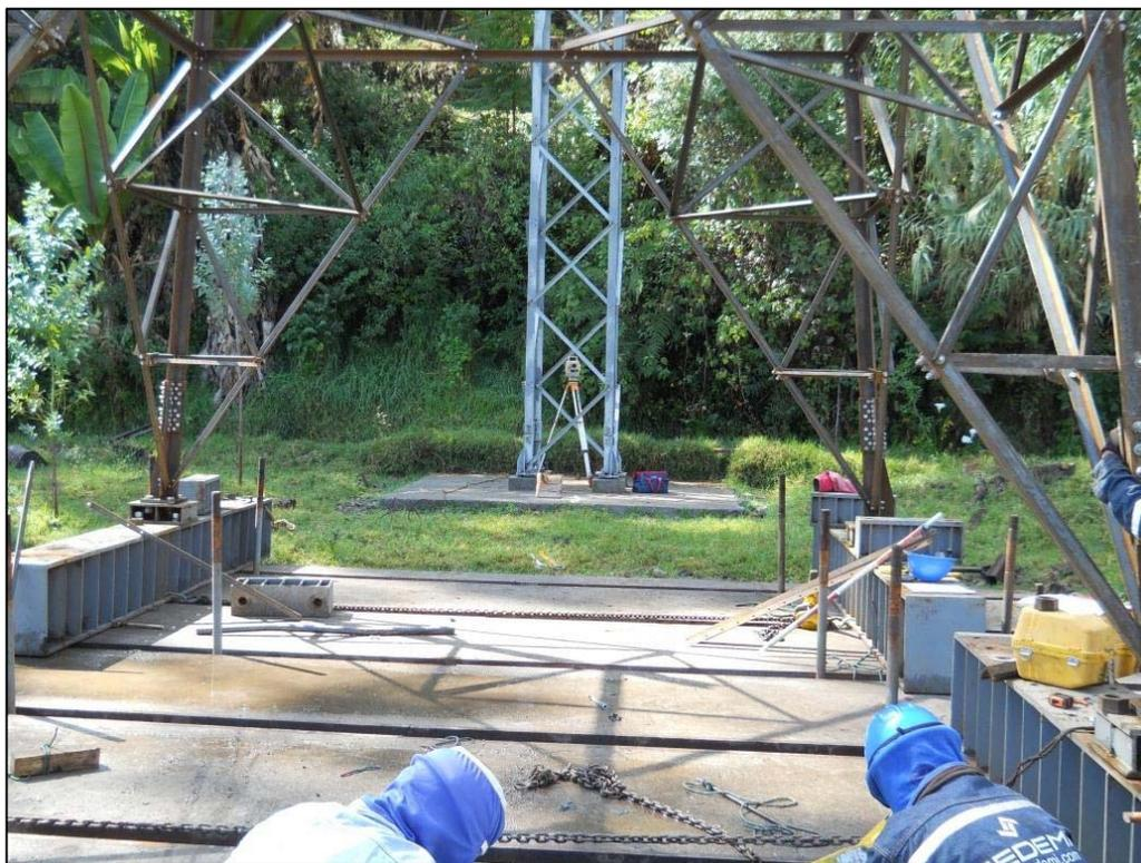
**Figura 120.** Fijación de las bases para la torre que se va a someter a prueba
