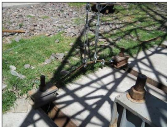
**Figura 91.** Anclaje de cables de carga verticales en crucetas
