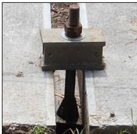
**Figura 32.** Dados de anclaje para cables de carga y soporte
