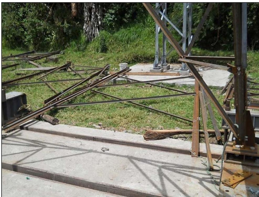
**Figura 122.** Preensamblaje de tramos inferiores de la torre a prueba
