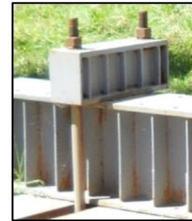
Figura 31. Ancla o grapa de sujeción para viga HEM 500.
