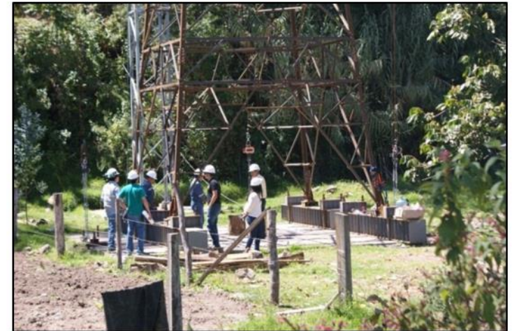
Figura 27. Cimentación principal para torre a prueba.
