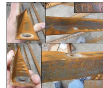
Figura 137. Celosía SP2-7; (a) y (c) vista de flejamiento del elemento; (b) y (d) agujero intermedio donde inicia la flexión del perfil
