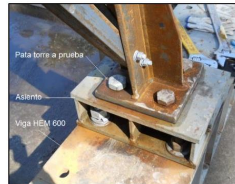
Figura 30. Asiento para pata de torre a prueba.
