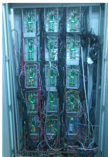
Figura 5.6.- Distribución actual de PLC.
