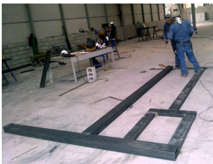
Figura 81 Unión de Tubos con Soldadura
