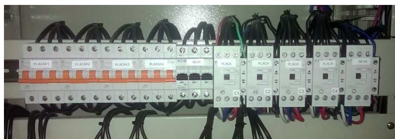
Figura 103 Conexiones de Potencia de las Resistencias Eléctricas
