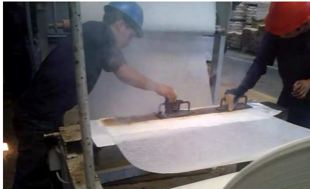
Figura 4 Empalme de Rollos de Fibra de Vidrio
