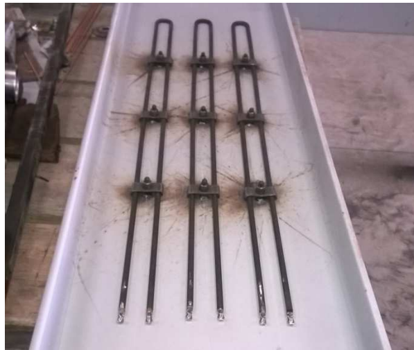
Figura 85 Resistencias Tipo U Acopladas a la Mesa de Empalme
