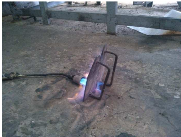
Figura 3 Proceso de Calentamiento de las Planchas Metálicas
