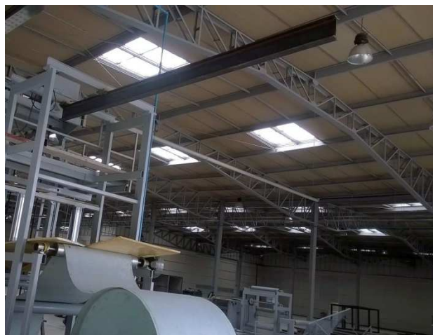
Figura 94 Viga IPE 20 Ensamblada a la Estructura
