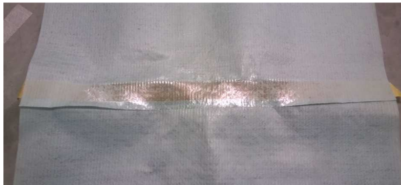
Figura 108 Empalme de Láminas de Poliéster
